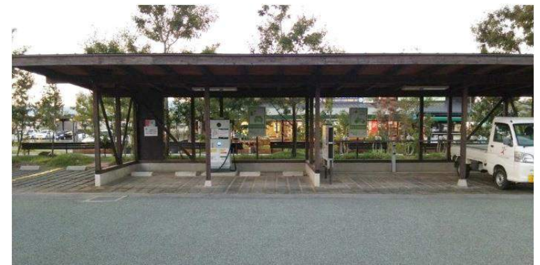
電気自動車・電気バイク充電設備
